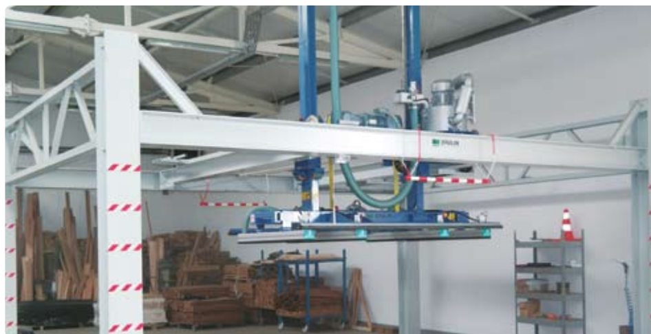
Solidna, stalowa rama układarki przytwierdzona jest kotwami na stałe do posadzki.
